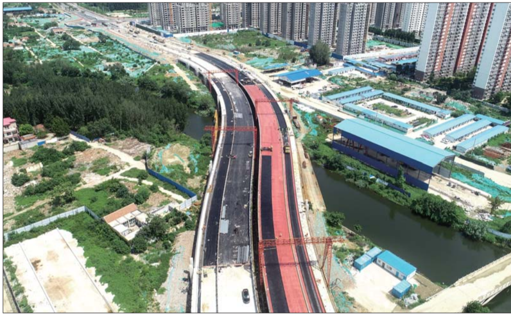
城区车站南路跨老运河桥施工进度迅速。 齐鲁晚报·齐鲁壹点见习记者 房体朔 摄
