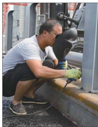
工人正在进行焊接作业。
