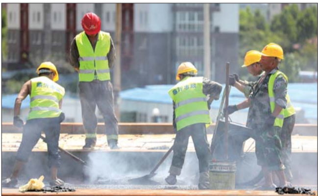
工人在铺沥青。
