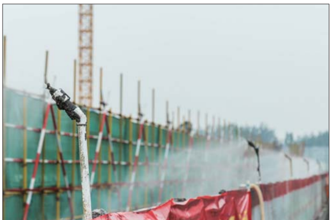
高压水枪投入使用。
