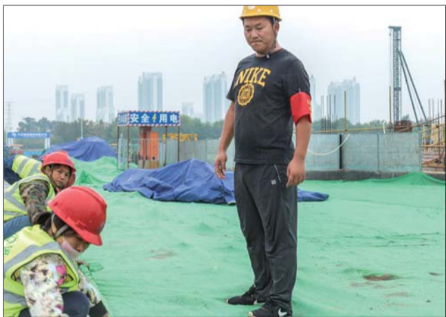
为裸露地面盖上防尘网。
