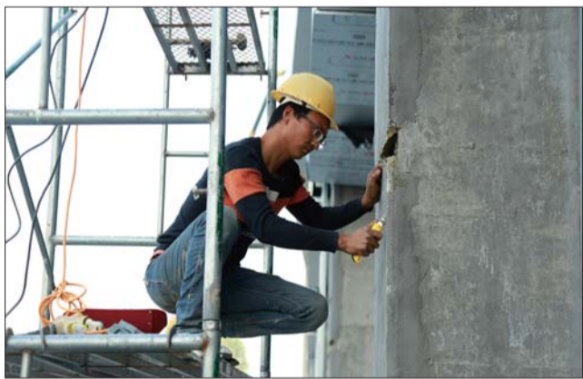
工作人员正在加紧施工。
