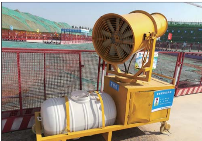
工地内的雾炮车。
