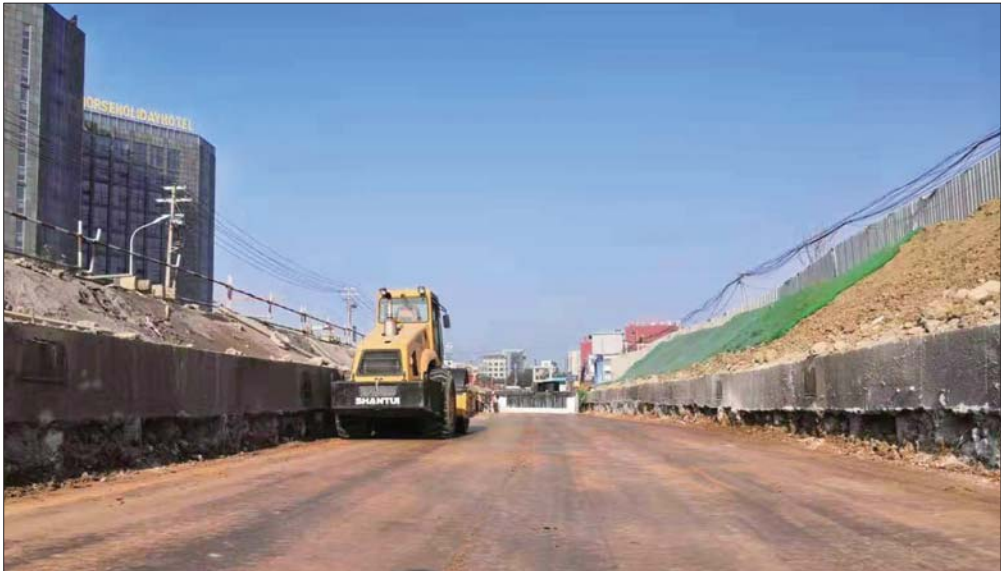
施工现场,压路机来回作业,将回填的土方压平整。 齐鲁晚报·齐鲁壹点记者 周惠娇 摄
