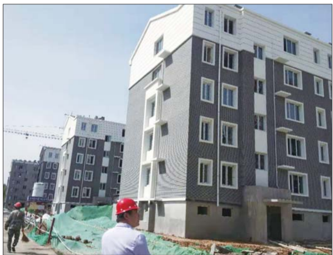
正在建设中的回迁房。
