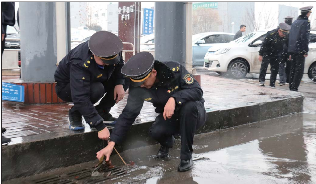
综合执法工作人员正在清理雨水井篦。
