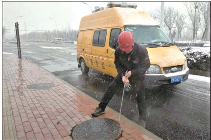
工作人员雪中巡视供热管道。
