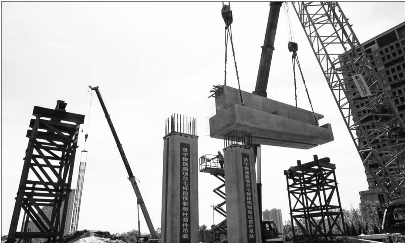
任城大道七标段首片盖梁正在吊装中。
