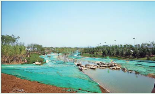
杨家河历城河段今年将建成景观河,温梁路以南正在施工。
