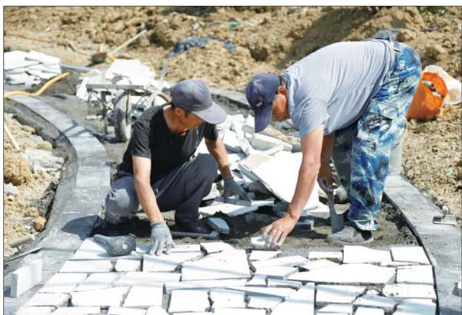
古泗河治理项目工人正在铺设景观步道。
