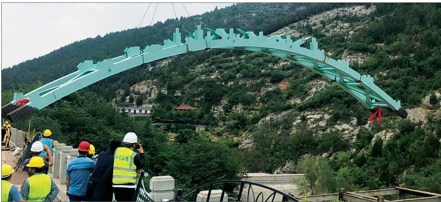
5月30日,历阳湖环湖步道工程拱桥完成了吊装。齐鲁晚报·齐鲁壹点记者 于悦 摄
