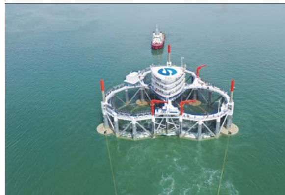
实施平台精就位作业。
