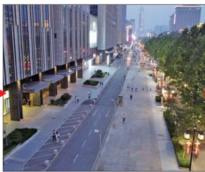
非机动车停车点拆除后,泉城路路面变宽敞。
