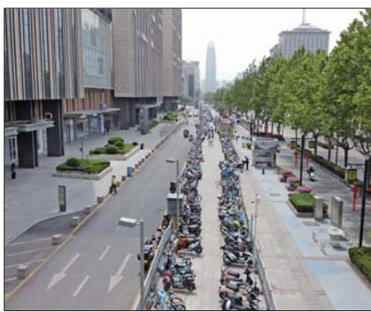
改造前,非机动车停车点占据了泉城路宝贵空间。
