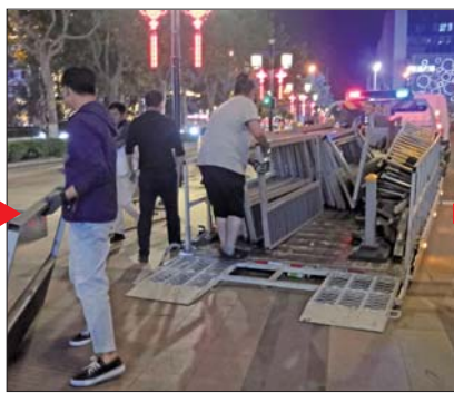
6月2日晚,非机动车停车点围栏开始拆除。
