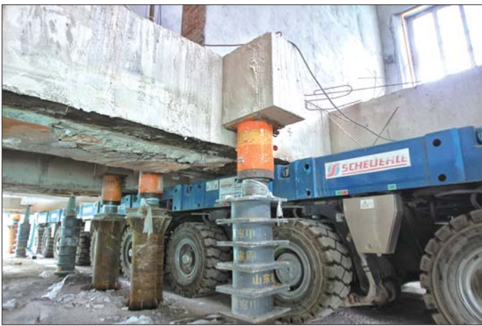
修女楼被顶升至1.65米高。 齐鲁晚报·齐鲁壹点记者 王鑫 摄
