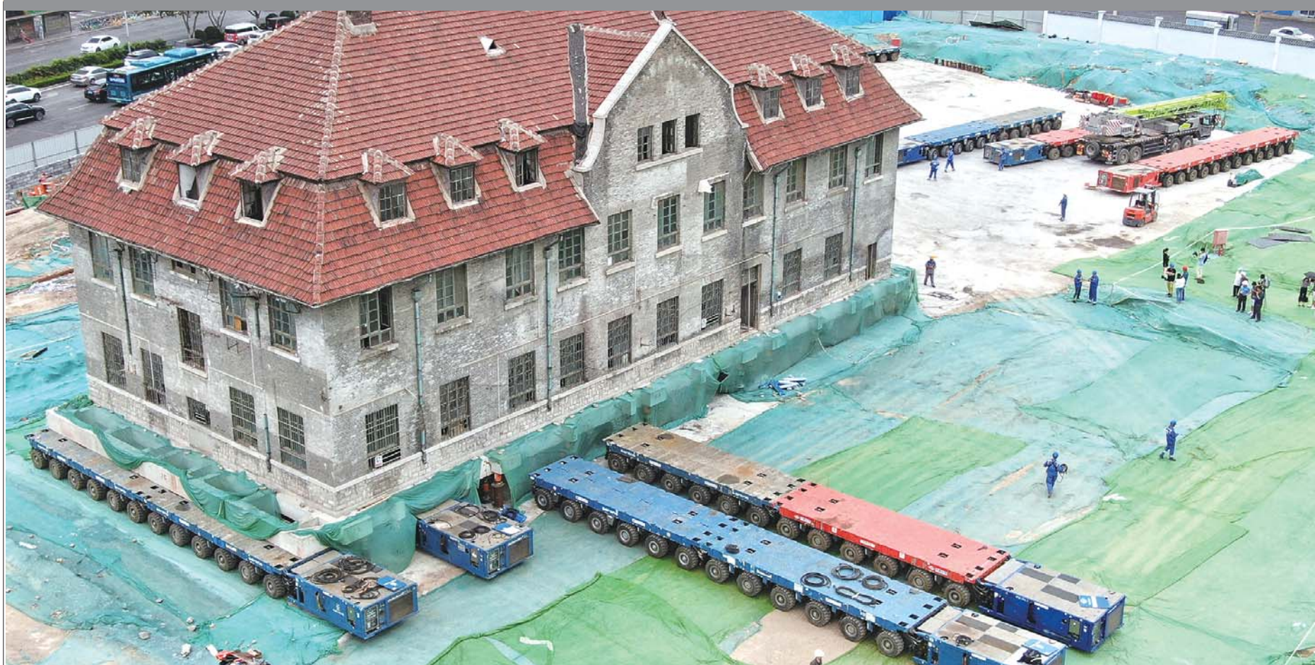
9日上午,大型液压平板拖车陆续进入老楼底部,10日上午,它们将拖动老楼进行平移。 齐鲁晚报·齐鲁壹点记者 王鑫 摄
