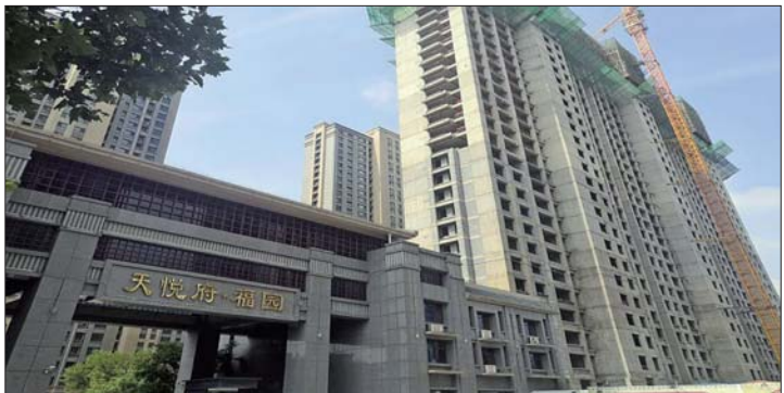
小区未完工的楼盘有塔吊正在施工。
