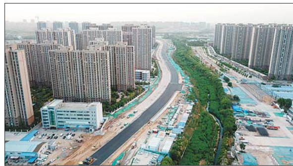
奥体西路北段东半幅铺沥青，西半幅道路主体结构完工。
