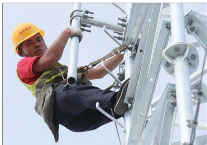
施工人员正在高达15米的基站塔上面安装构件。
