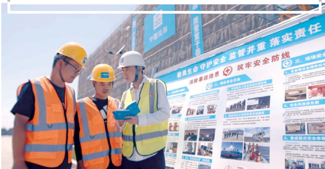
中建八局二公司党员先锋队开展工友安全教育。
