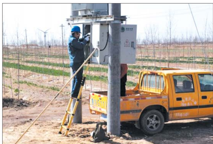
庆云供电工作人员给变压器装计量表
