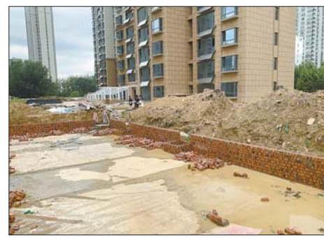
在建的大型垃圾中转站就在小区内,离住宅很近。
