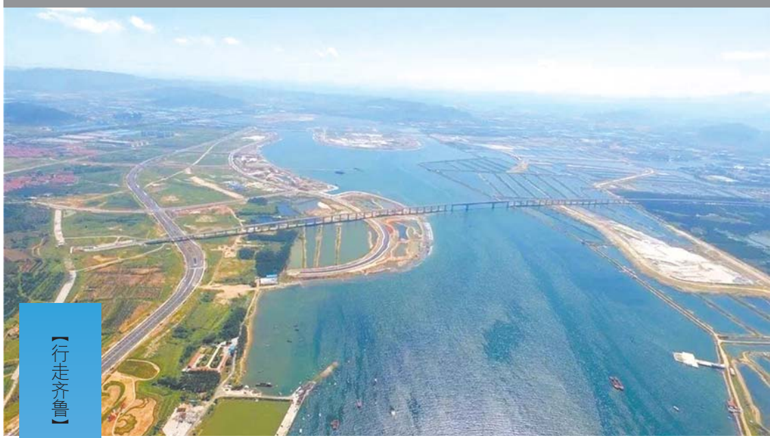
双岛湾跨海大桥
