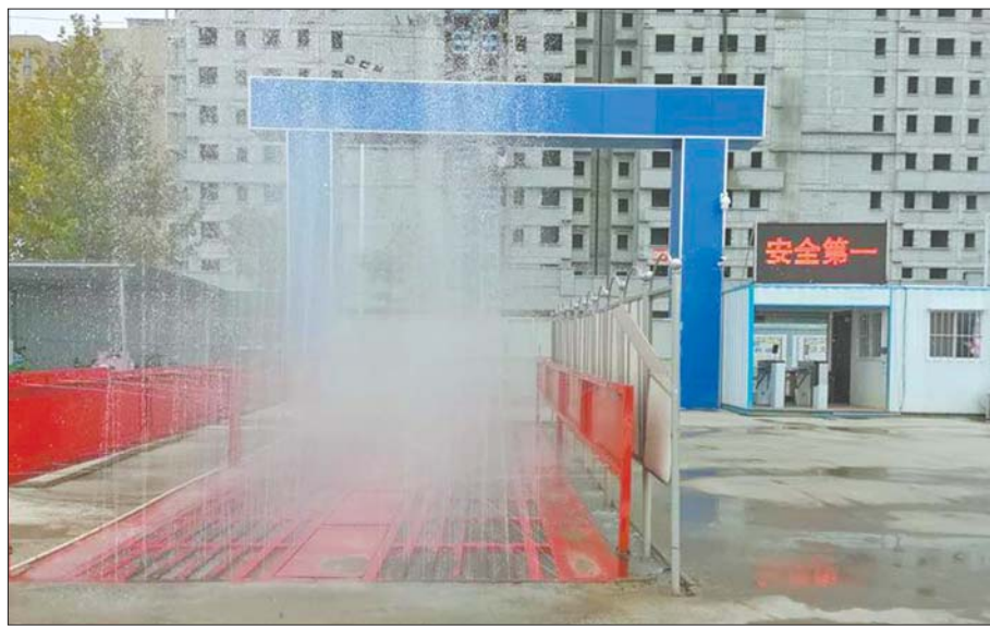
施工现场正在进行除尘处理。
