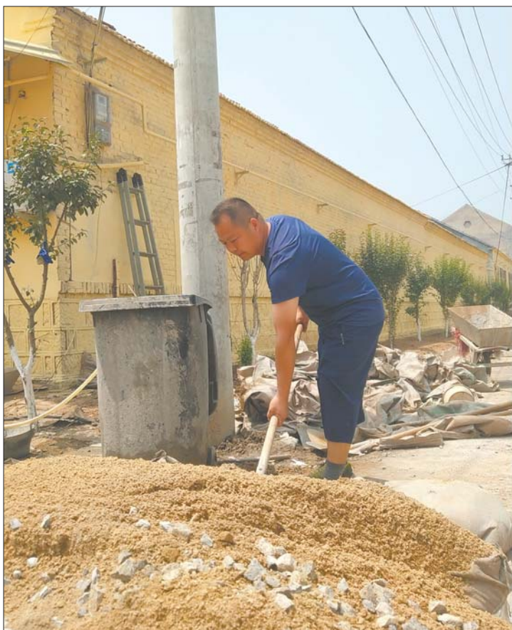
李齐超在施工现场铲沙料。
