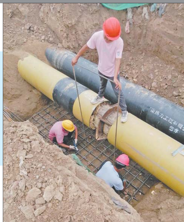
管网施工现场。
