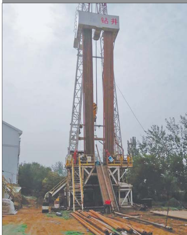
新热源管网项目建设现场。
