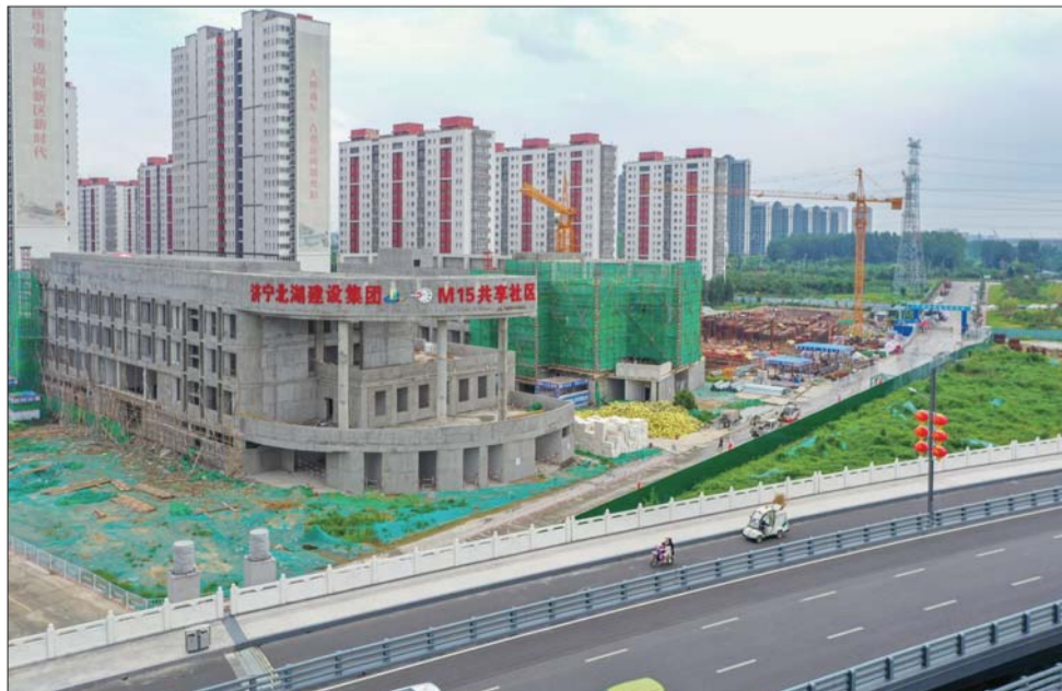
建设中的M15共享社区。
