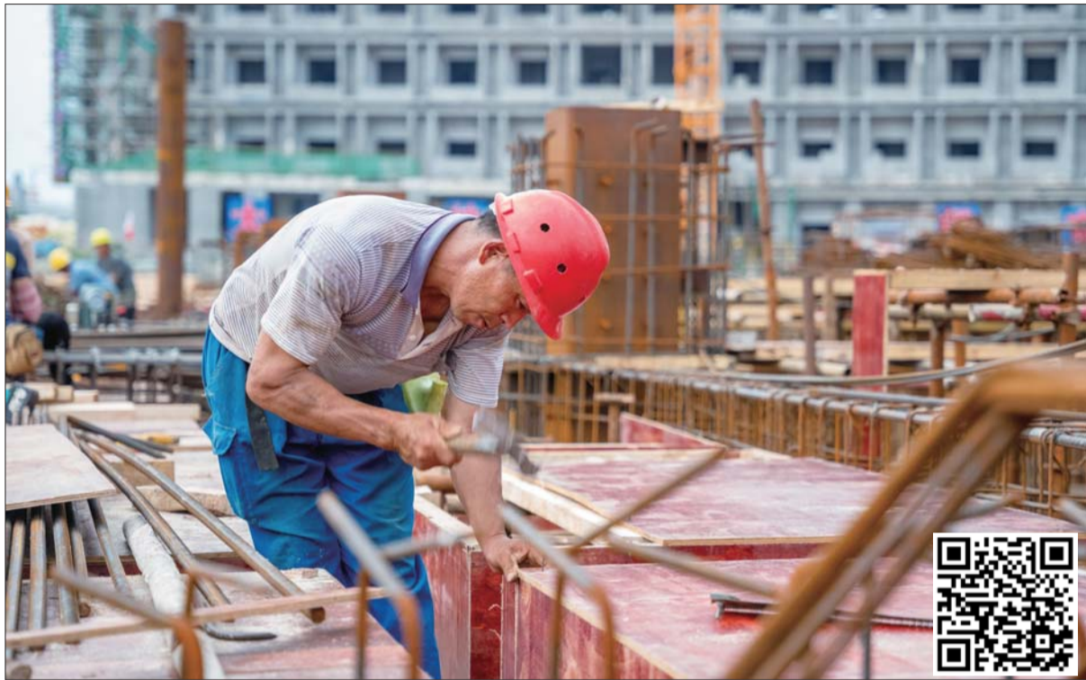
航运路康养中心项目现场，工人正在安装模板。
