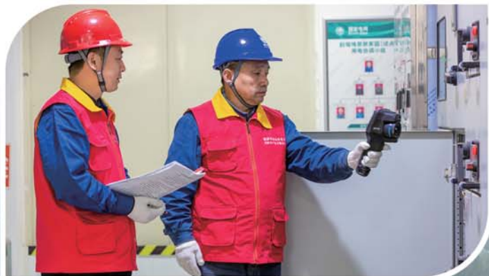
查看电力设备运行状况。
