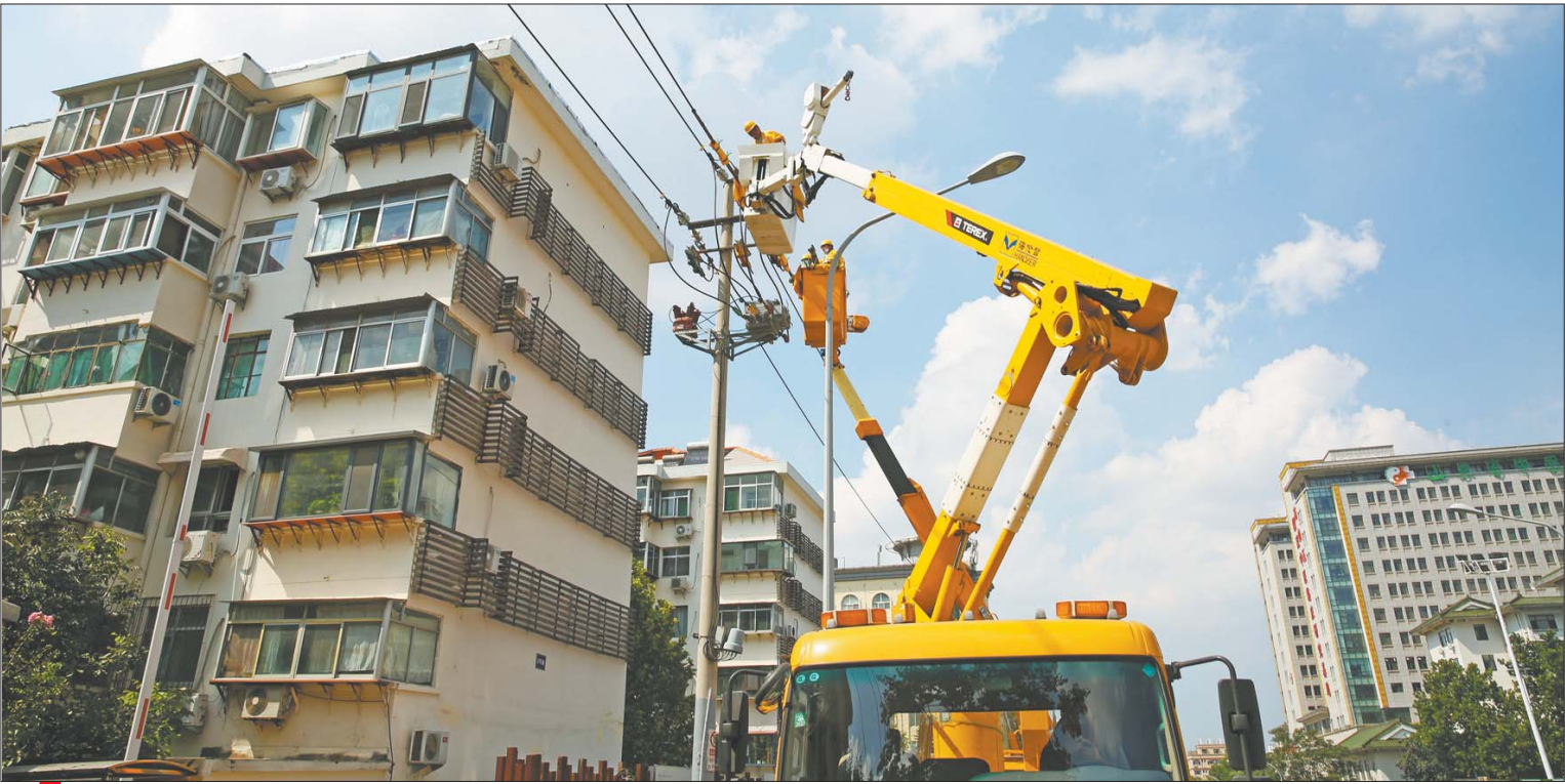
济南供电公司带电作业人员正在对历下区10千伏广十线开展带电作业。
