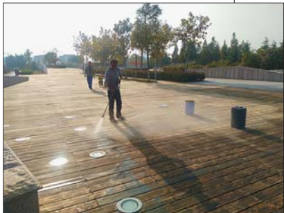
住建局场馆中心为奥林匹克公园木栈道喷漆
