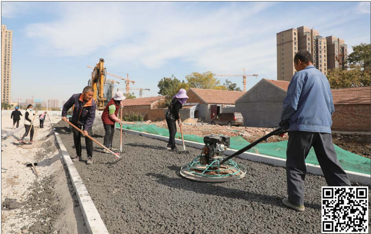
工人正在铺设透水混凝土。
