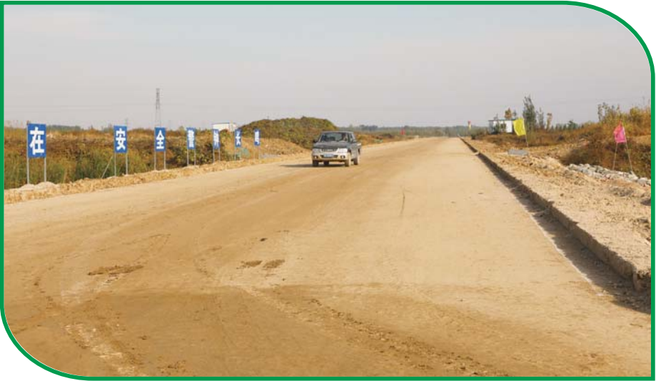
完成石灰土施工的石佛路东延工程。
