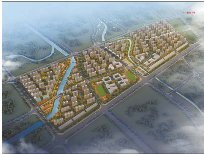
淄博文昌嘉苑小区是全国最大的钢结构装配式建筑小区。
