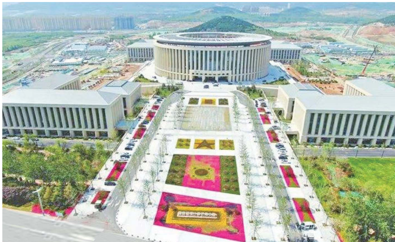
济南超算中心科技园一期,采用装配式建造方式仅用108天,创造了新的济南速度。
