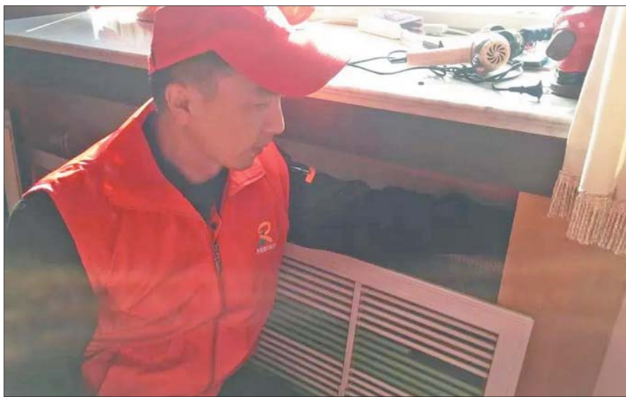
供热管家上门为居民维修暖气片。
