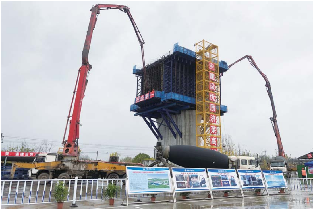
济莱高铁跨胶济铁路转体桥浇筑现场 本报记者 王瑞超 摄
