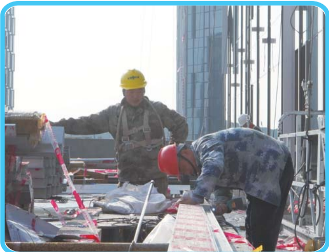
项目现场500多名工人同步施工。
