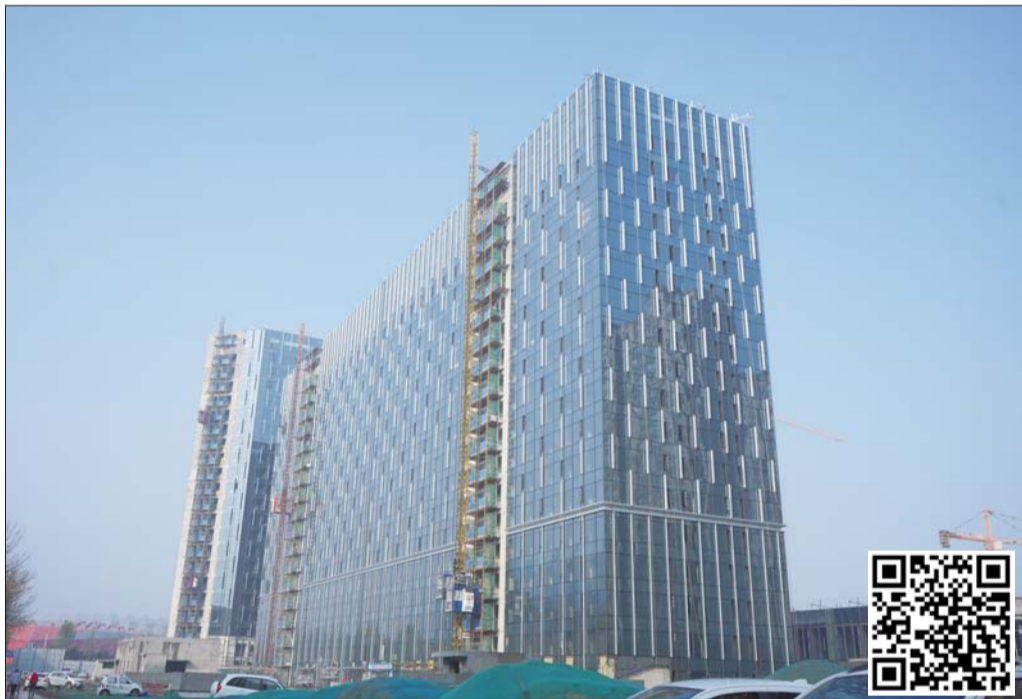
城投·星城广场项目外立面装饰基本全部完工。
