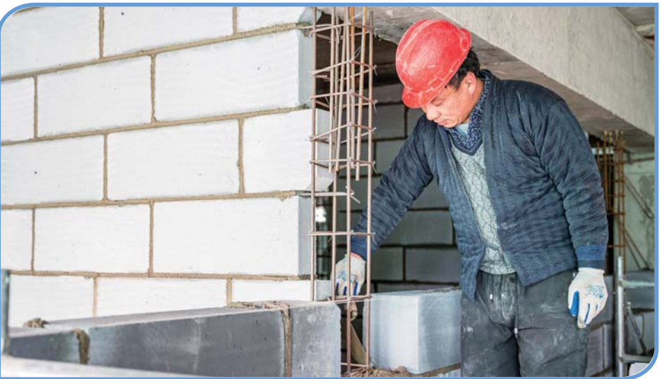
工人正在砌筑填充墙。
