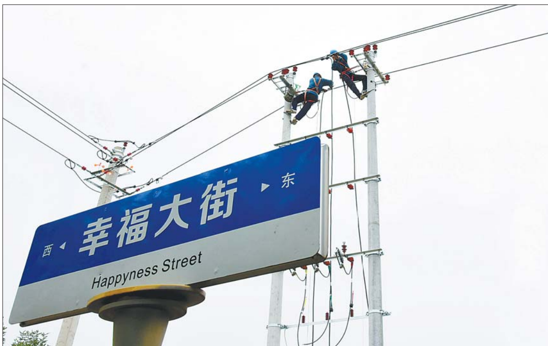
▲国网济南市济阳区供电公司员工改造提升农村电网,保障村民用电可靠。陈彬 摄
