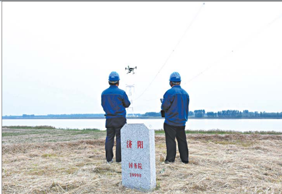
国网济南市济阳区供电公司员工利用无人机巡视±660千伏东直流过境线路。陈彬 摄
