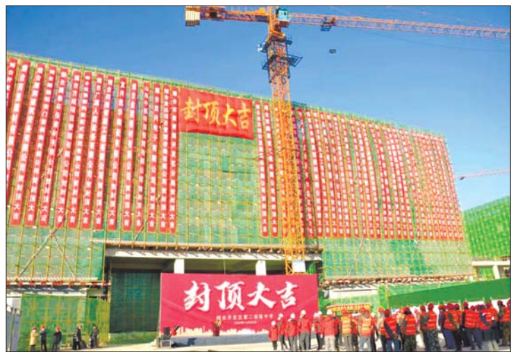
烟台开发区举行第二高级中学建设项目封顶仪式现场。
