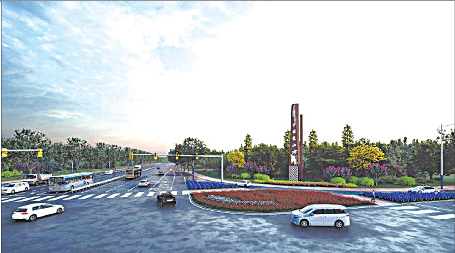
龙山街道驻地提升建设工程。
