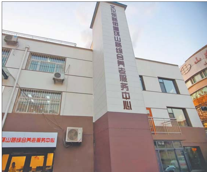
文化东路街道环山路综合养老服务中心。
