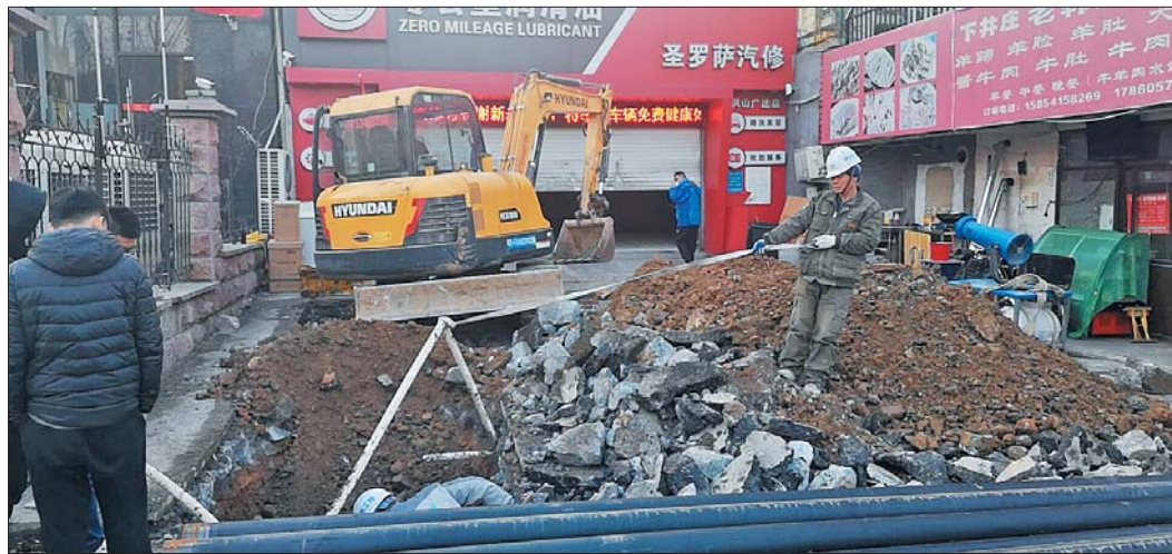
有关部门正在加紧施工,尽快为居民通上自来水。齐鲁晚报·齐鲁壹点记者 程凌润 摄
