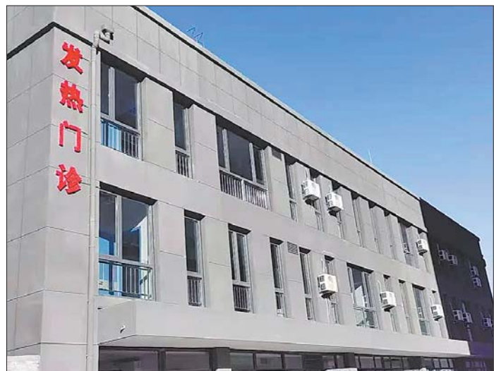
济阳区人民医院发热门诊建成启用。
