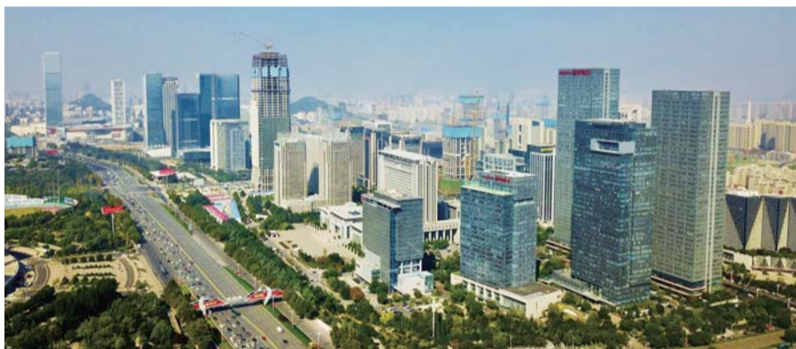
国际金融城的工程项目正在建设中。
