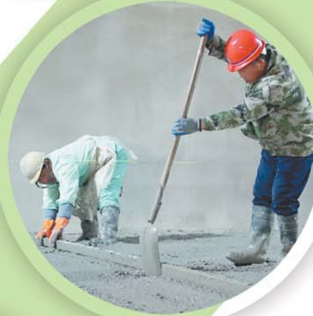
► 曲阜天博扩建项目,工人在加紧施工。
