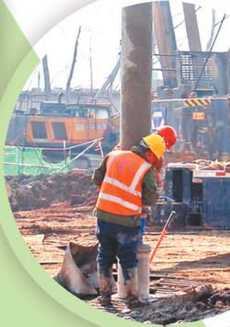
▼ 临沂奥体中心项目施工现场。
