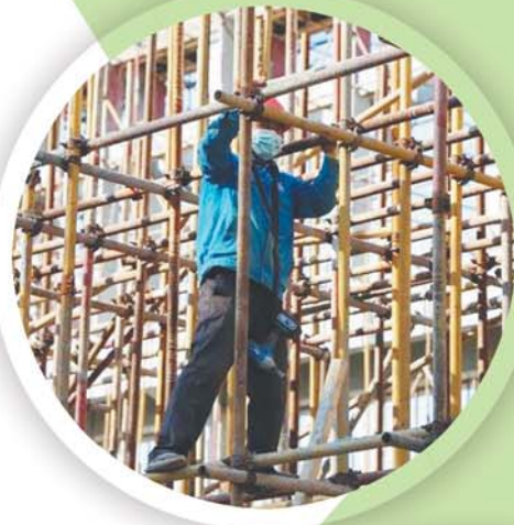
► 大年初八,在滨州市滨城区华纺股份“退城入园暨智能绿色工厂建设”项目现场,工人已经进场施工。
