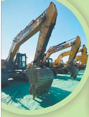
► 淄博吹响2021年春季重大项目开工“集结号”。
