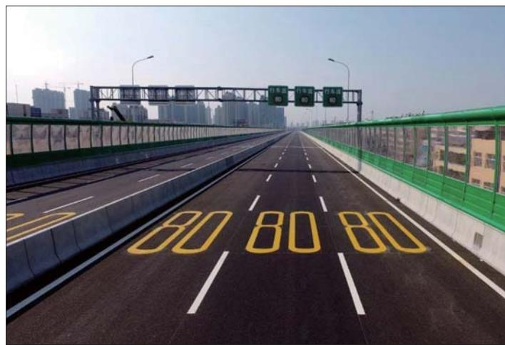
通立交南终点至宝山路-昌国路互通立交。工程包含主路(高架桥和地面段)、辅路、互通立交(1座)、匝道、雨污水管线、道路照明、交通工程、绿化等。
