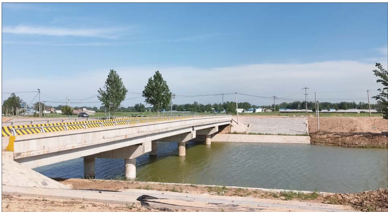
涝洼地治理项目苏河河道治理。
