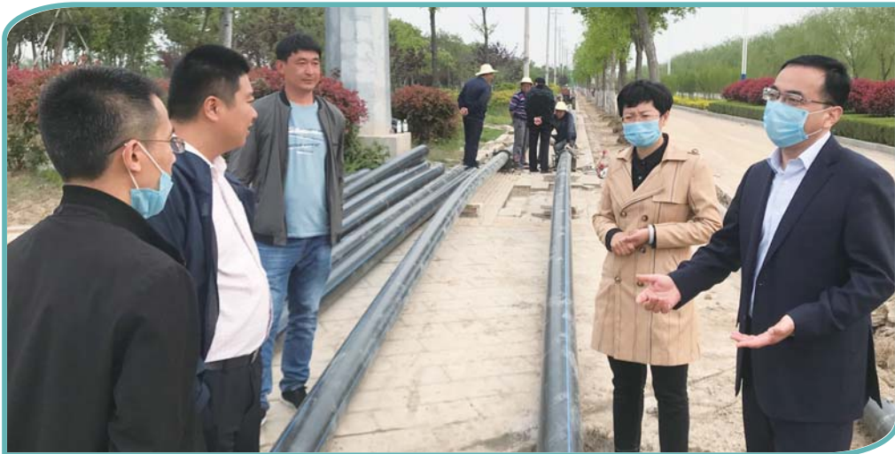
城乡供水一体化工程建设。
