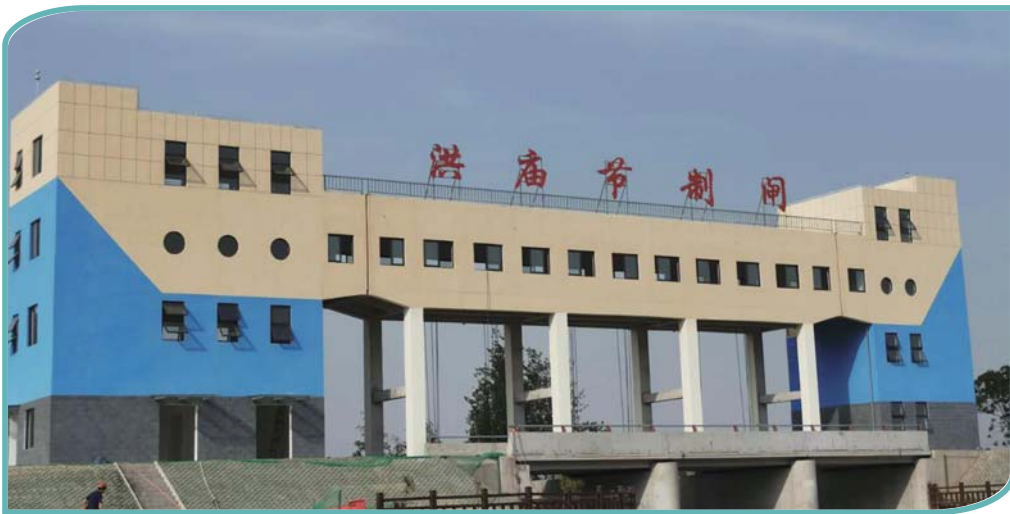
病险水闸除险加固项目洪庙节制闸。
