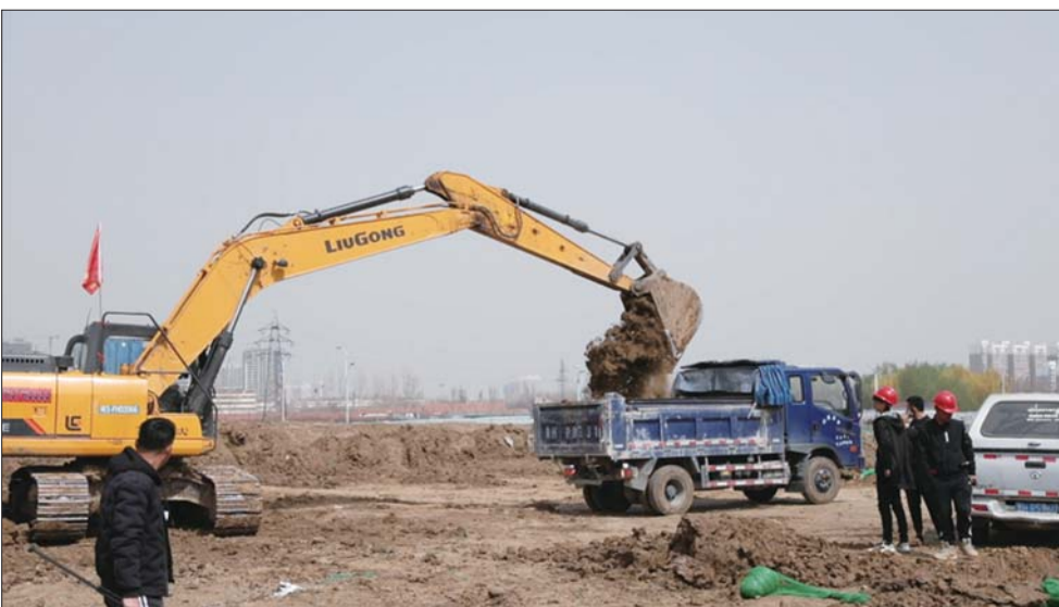
新运河北段绿化工程项目施工现场。
