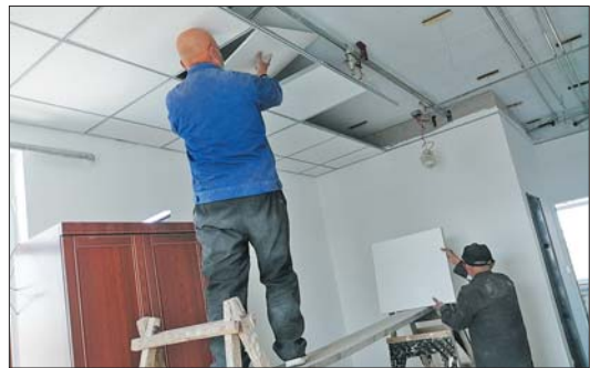
敬老院改造提升施工中。
