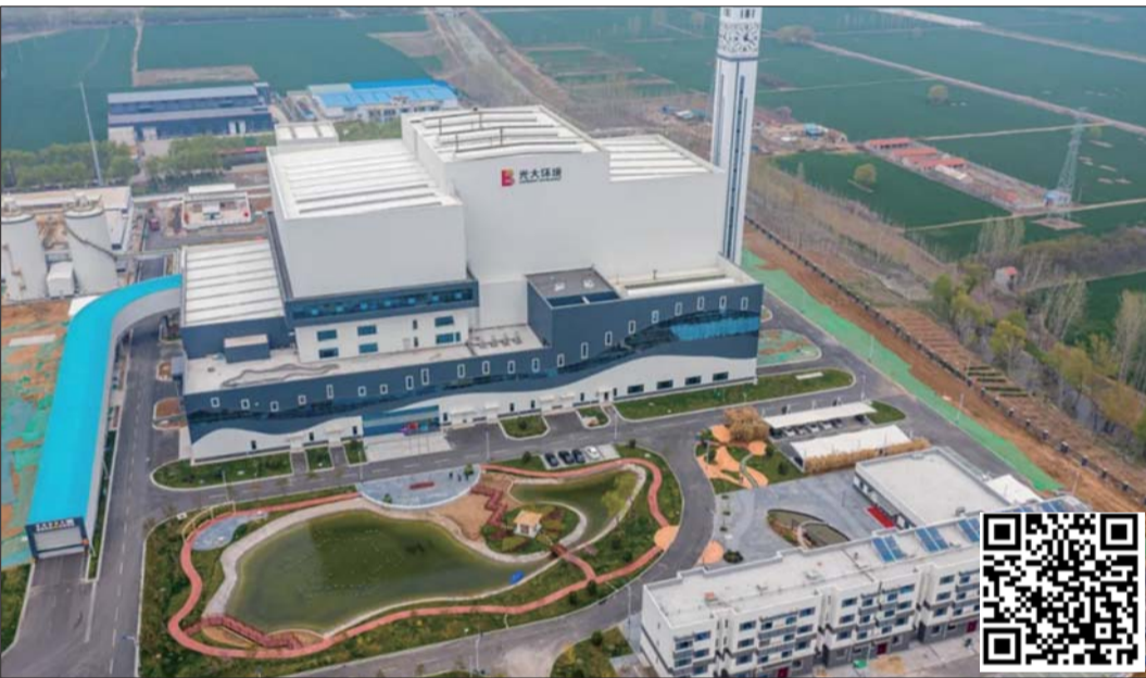
微山这家公司日处理400吨生活垃圾。
